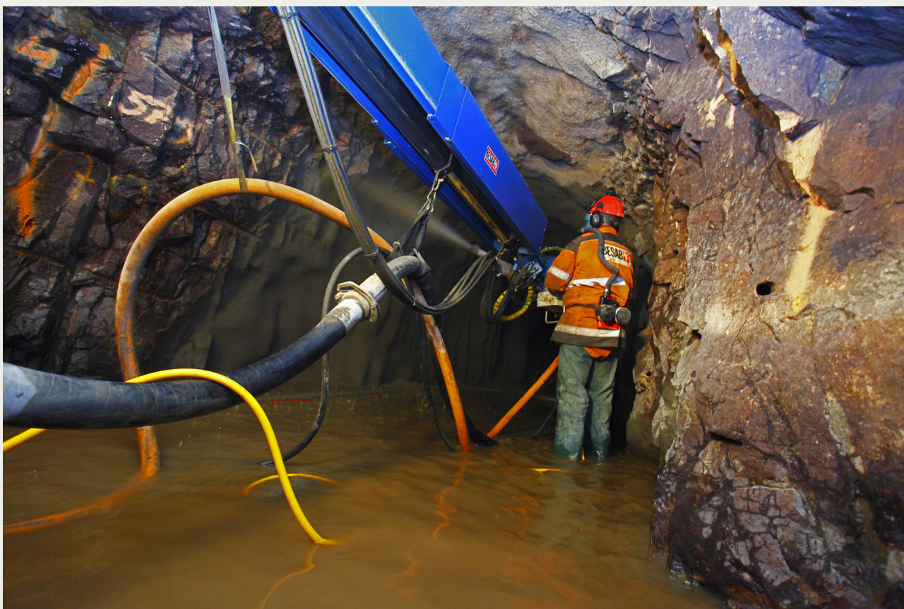
Betongsprutning i LKAB.
